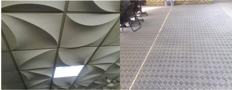
صورة توضح الارضية والسقف وداخله وحددة الانارة
